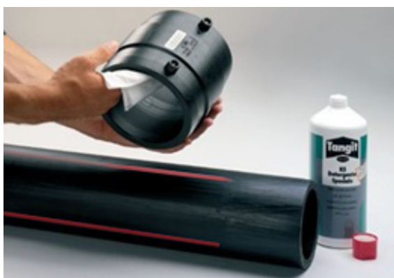
Рис.10 Обезжиривание фитинга
