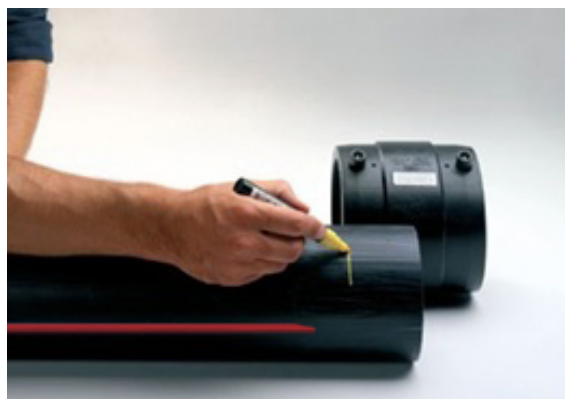
Рис.16 Нанесение отметки после очистки
