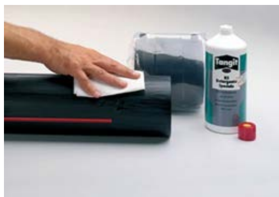
Рис.11 Обезжиривание трубы
