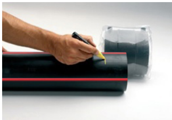
Рис.5 Отметка длины зачистки маркером
